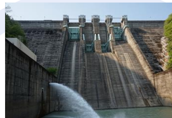
人が近づけない設備の点検
