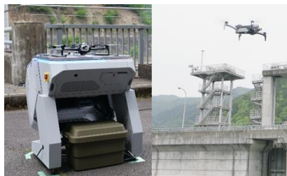
「Skydio Dock for X10」を活用した遠隔自動ダム点検実証
