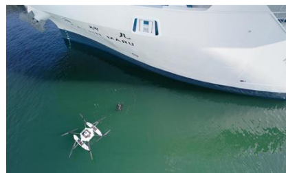
水空合体ドローンにより船底点検自律型無人探査機(AUV)利用実証
