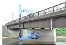
橋梁点検車による調査
