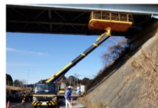
高所作業車による調査
