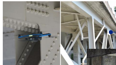
ドローンによる橋脚下部の点検
