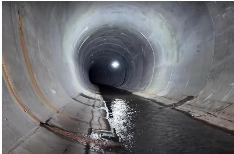
トンネル点検のイメージ
