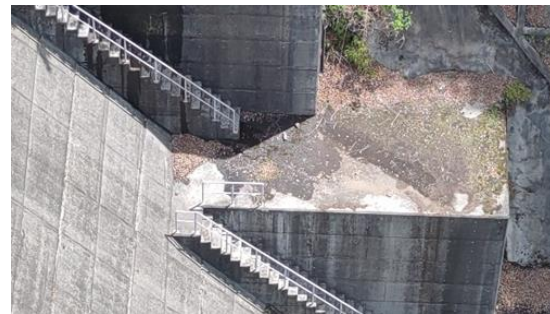
<ダム堤体の撮影>
