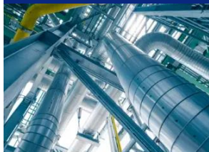
ボイラー内部
