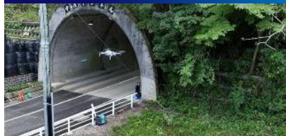
② 中屋トンネル (輪島市)
